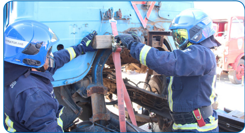
Estabilización longitudinal corta (costado).
